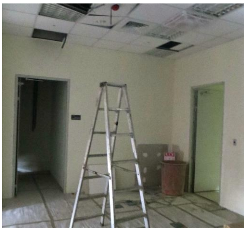
吳罹災使用超過 2 公尺以上 合梯進行高處作業而受傷
