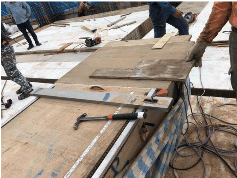
木材加工用圓盤鋸未設置覆蓋等防護設施。
