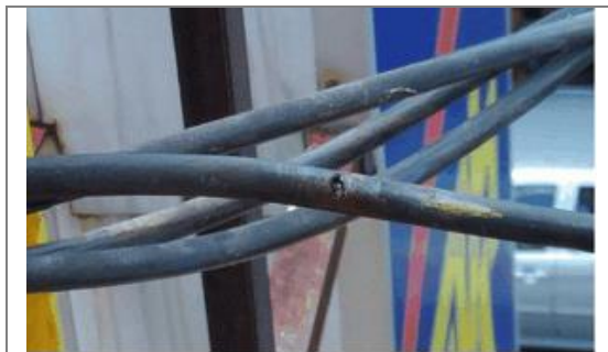
帶電破皮之電線。
