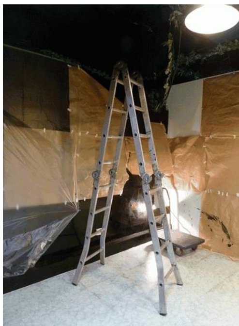
陳罹災者使用超過 2 公尺高之合梯進行天花板油漆作業時墜落受傷。
