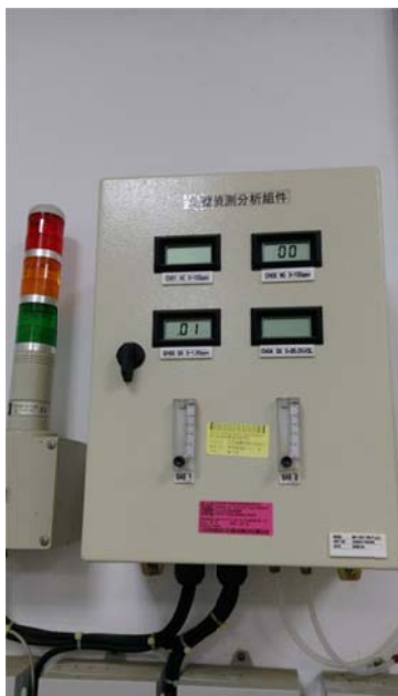
1. 危害氣體偵測分析組件 2. 危害氣體偵測分析組件 3. 數字式陶瓷加熱器
