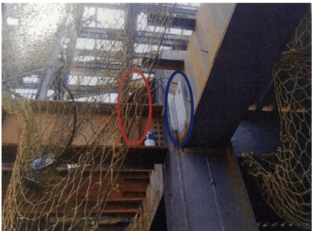
徐罹災者在工地 11 樓鋼樑上（紅色圈選處）進行鋼樑接合處除鏽補漆作業（藍色圈選處）時，不慎墜落至 10 樓造成右手骨折。
