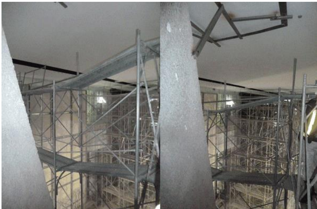
罹災勞工作業之施工架
