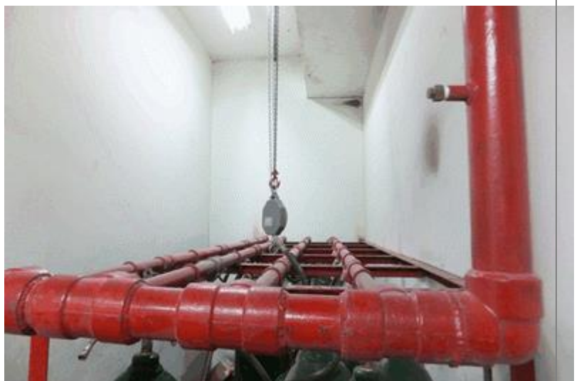
安裝之吊秤，下方為鋼瓶存放區共存放 46 支二氧化碳鋼瓶。
