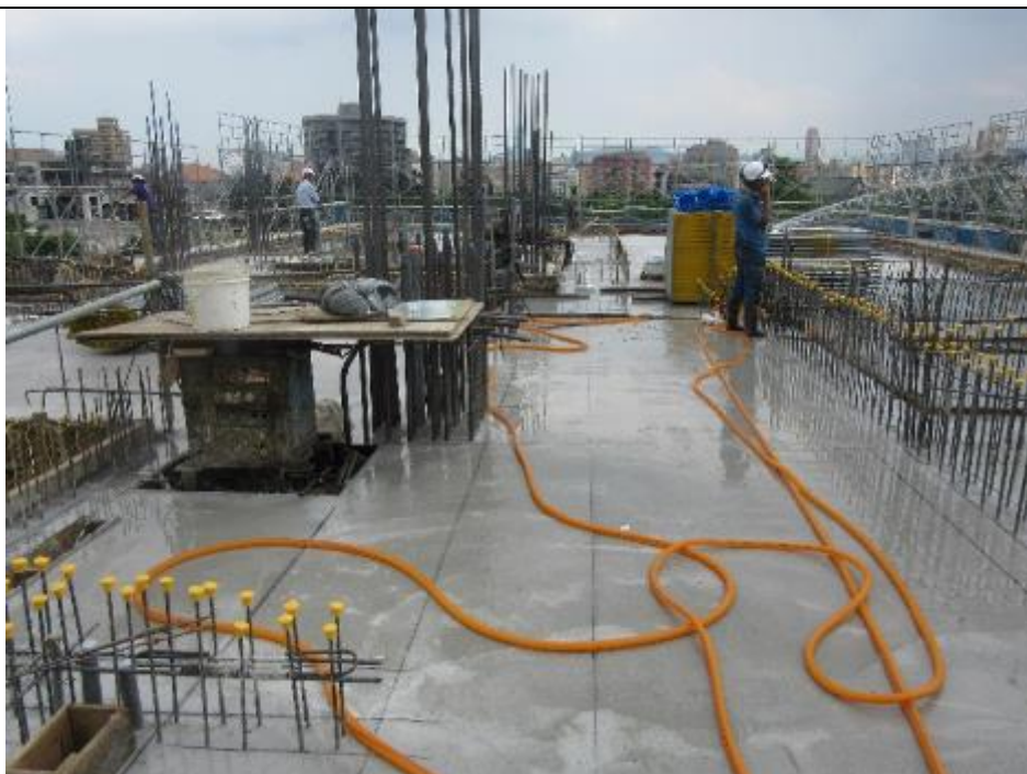
7 樓樓板（已完成混凝土灌漿作業）
