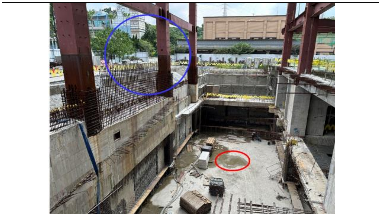
吊車於一樓平台由負責人操作起重機（藍圈），黃姓罹災者倒臥在地下二樓樓板（紅圈），地下二樓樓板陽光可直曬。
