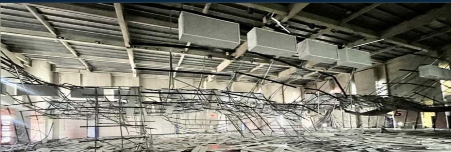
獨／桃園八德運動中心初步鑑定結果出爐！疑吊架設計瑕疵
