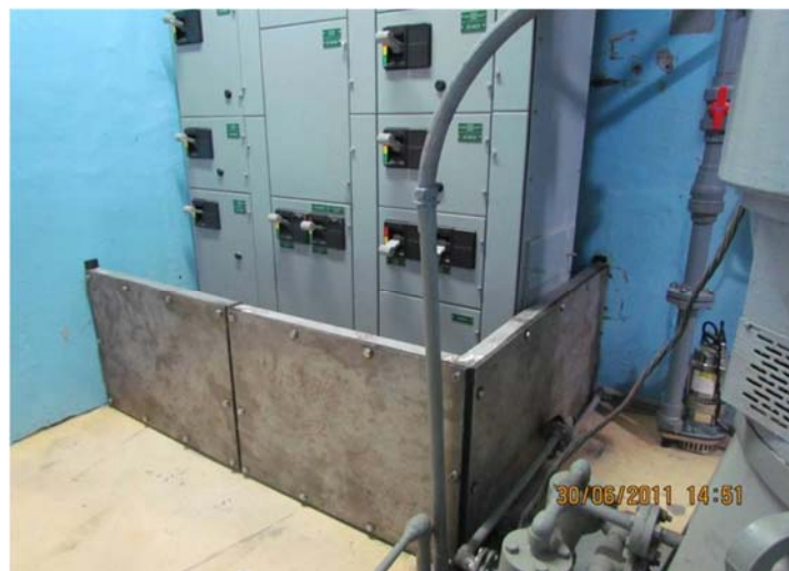
馬達控制中心防淹水短牆
