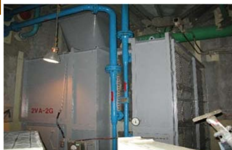
泵室冷卻系統
