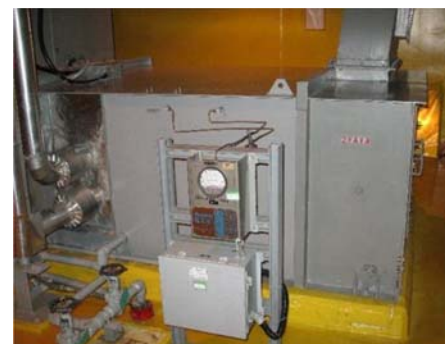
穿越器室冷卻系統VA1A~D
