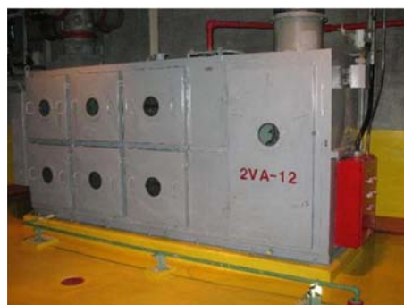
反應爐輔機廠房排氣系統VA12
