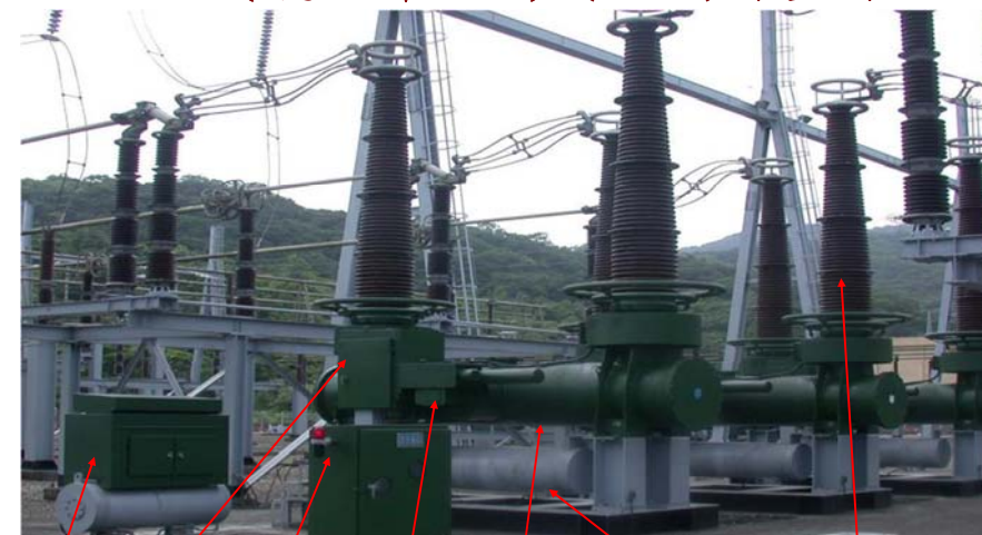
空壓機組 操作機構箱 現場控制箱 驅動機構 遮斷器 空氣儲存槽 瓷礙管
