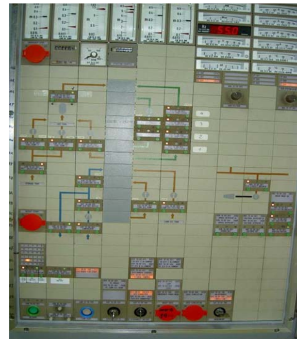
第五台柴油機 現場控制盤
