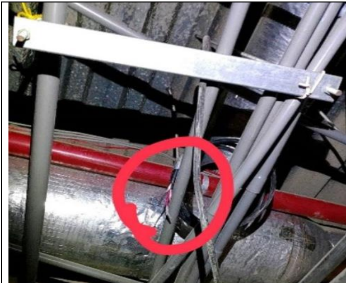
天花板上端部未絕緣之三芯電纜線(為避免災害擴大，端部已用絕緣膠帶絕緣)
