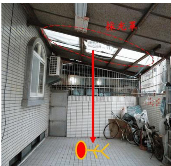
罹災勞工踏穿採光罩後墜落至地面。
