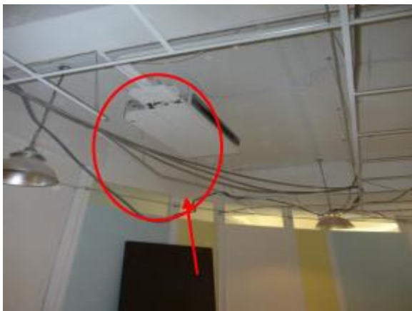
包覆位於輕鋼架上方之冷氣（高度約 3.4 公尺），避免後續進行牆面油漆工程時弄髒該冷氣。
