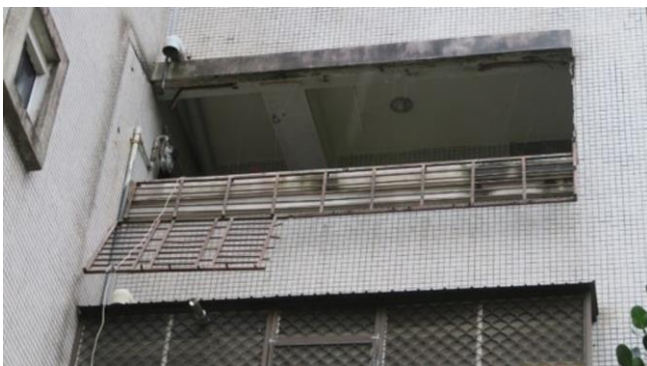
災害現場進行 7 樓後陽臺防盜凸窗拆除作業
